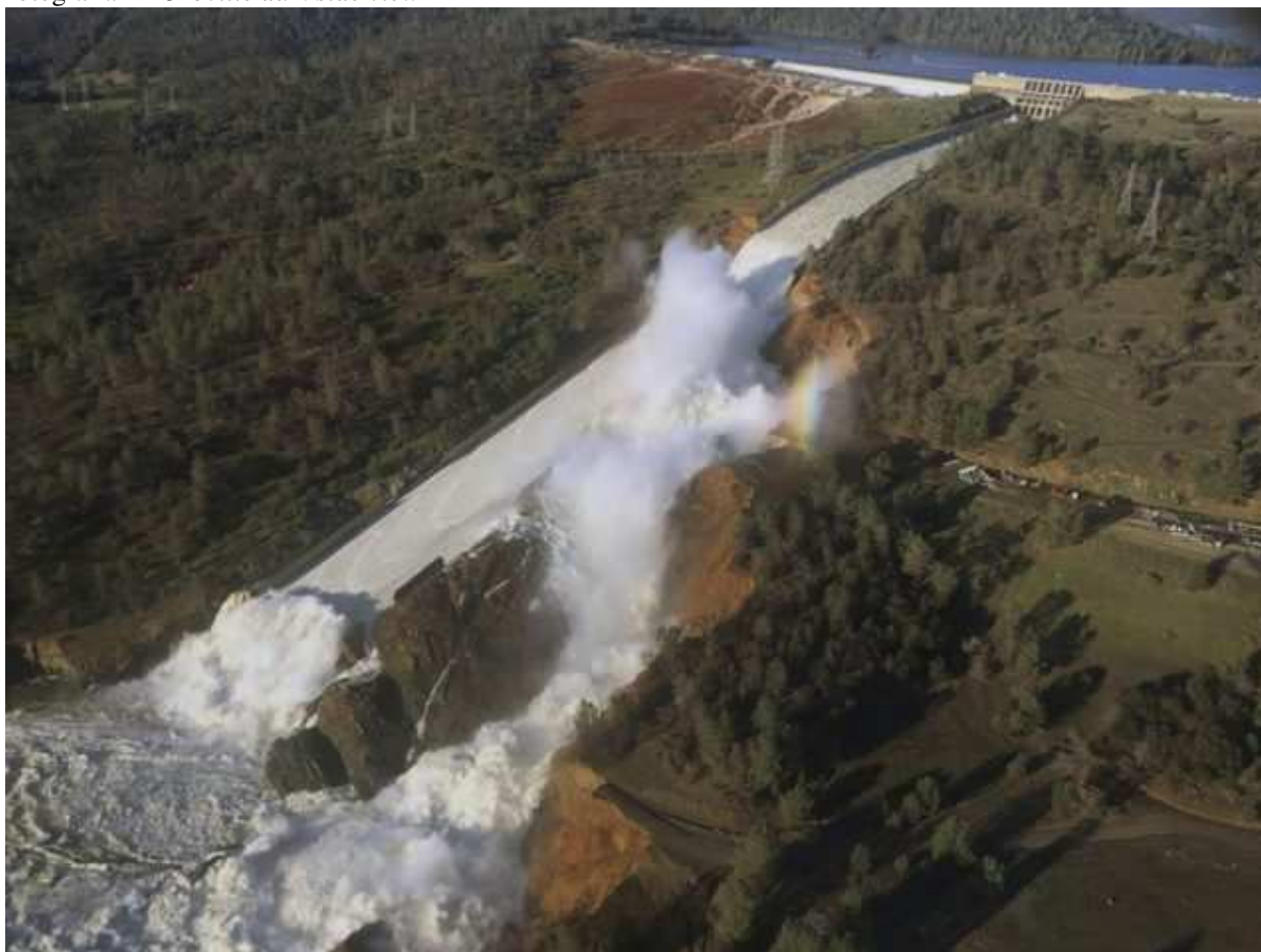
Fotografia 2 - Oroville dam side view
